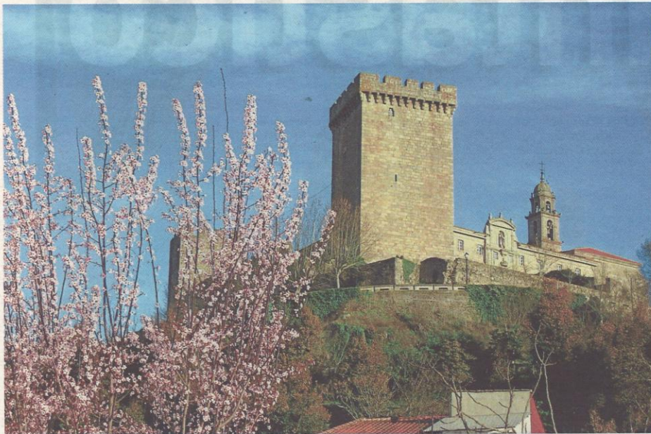
Conjunto monumental compuesto por el castillo y el monasterio de San Vicente del Pino, en el municipio lucense de Monforte. Foto: Angar
