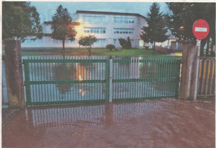
El desbordamiento del pequeño arroyo de Marín llegó al recinto del colegio Eloísa Rivadulla. ROÍ FERNÁNDEZ
